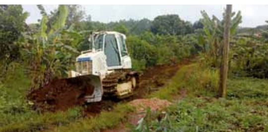
Planierarbeiten für den Bau des neuen Zentrums „Center of Excellenz for Addiction“ von HaB
