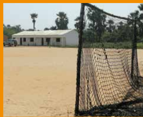
Neues Schulgebäude und Sportplatz in Kinak
